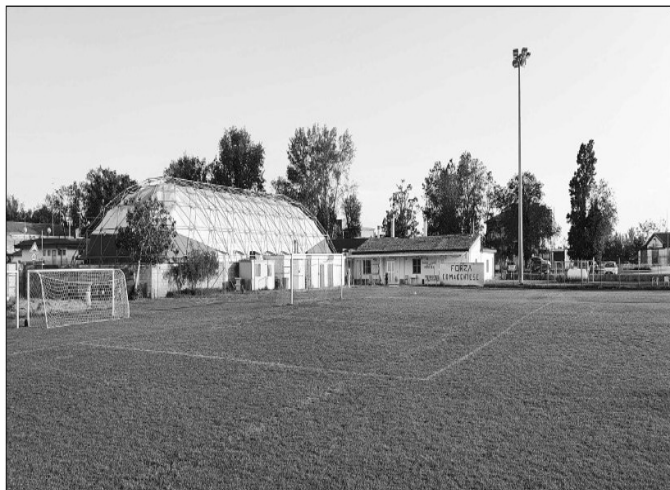
Fotografia dello stato di fatto degli spogliatoi; vista da Nord
